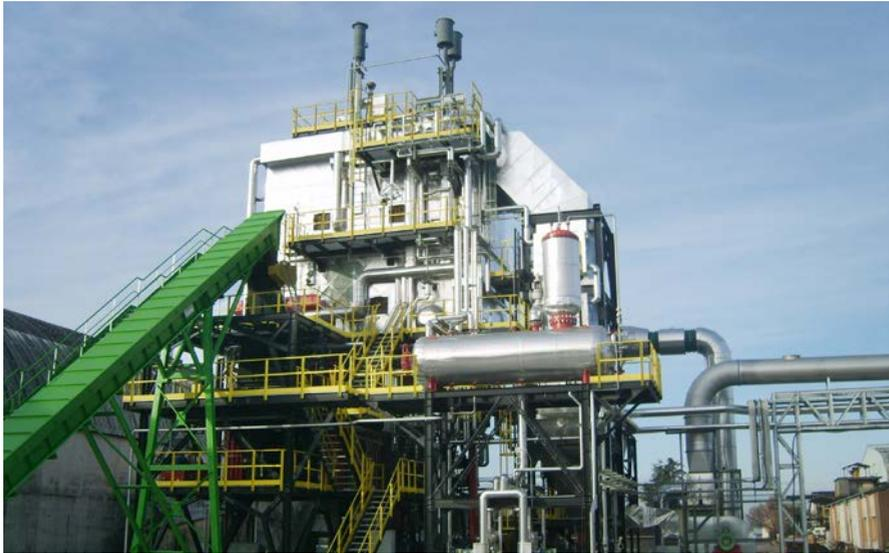
Bono Sistemi, azienda leader italiana che vanta un'esperienza ormai cinquantennale nell'ambito della cogenerazione a partire da diverse tipologie di biomasse, vergini e trattate, opera nella progettazione e costruzione, nelle officine di proprietà di Milano e Biella, di generatori di vapore saturo e surriscaldato e di generatori di calore a olio diatermico, di potenza variabile tra 5 e 50 MWth.
