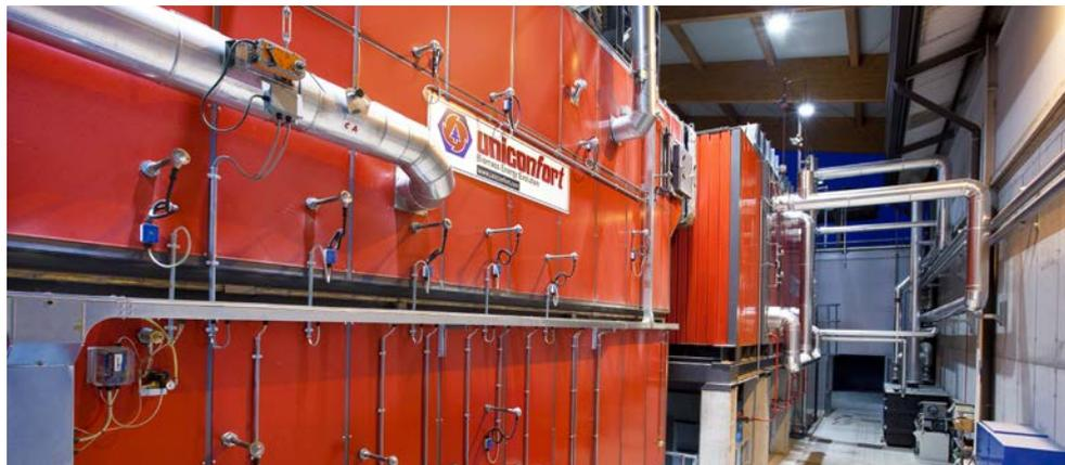
Forno di Combustione e Caldaia Uniconfort
