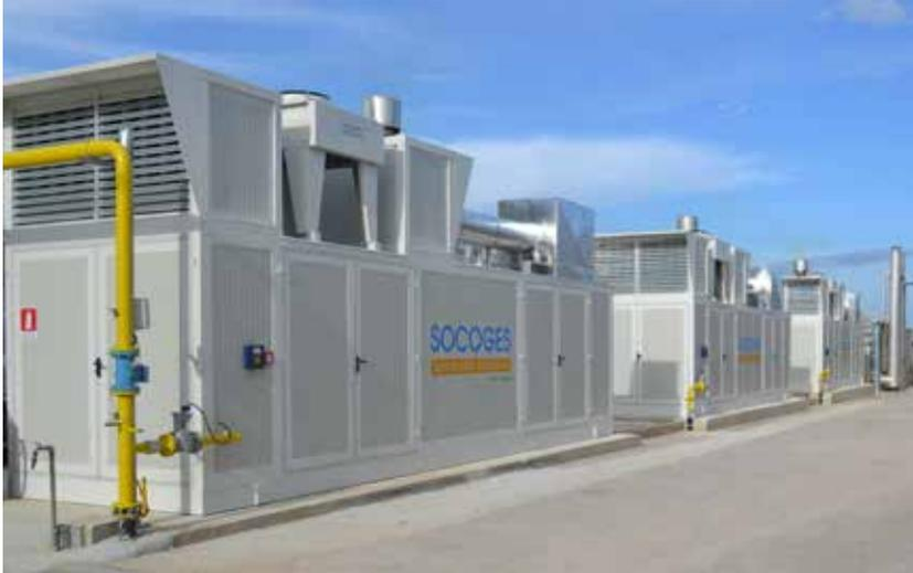
**FIGURA 2 - L'impianto di cogenerazione presso Az. Agricola F.lli Lapietra con i tre cabinati realizzati con motori DOOSAN modello GV222TI (12V, 22 litri, 350 kWm, @1500 rpm)**
