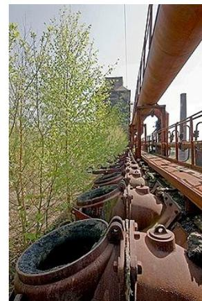
*Fig. 13 – Dettaglio delle bocche di caricamento dei forni ad Anderlues (Belgio, 2010)*
