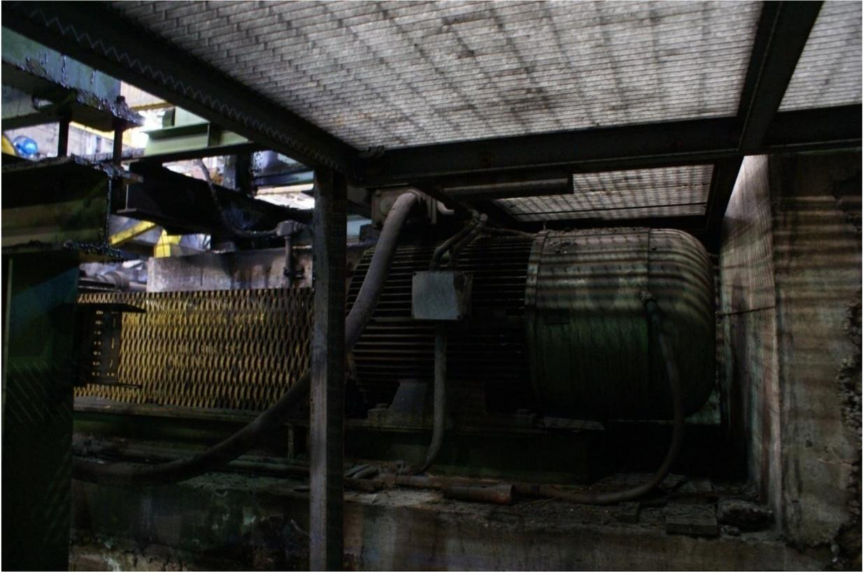
*Fig. 67 – Motore elettrico per movimento verticale rastrelli mobili*
