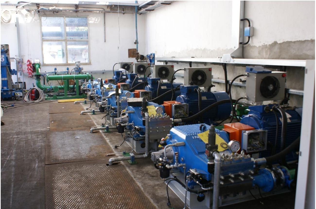
*Fig. 29 – Centrale di pompaggio discagliatura*
