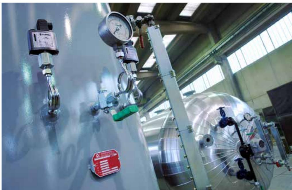
L'Accumulatore di Vapore serve ad assorbire le brusche variazioni di richiesta da parte dell'utenza. Ha la funzione di "POLMONE" di riserva, permettendo alla caldaia di lavorare in modo lineare. I vantaggi più evidenti che si ottengono da un accumulatore di vapore sono principalmente due:
