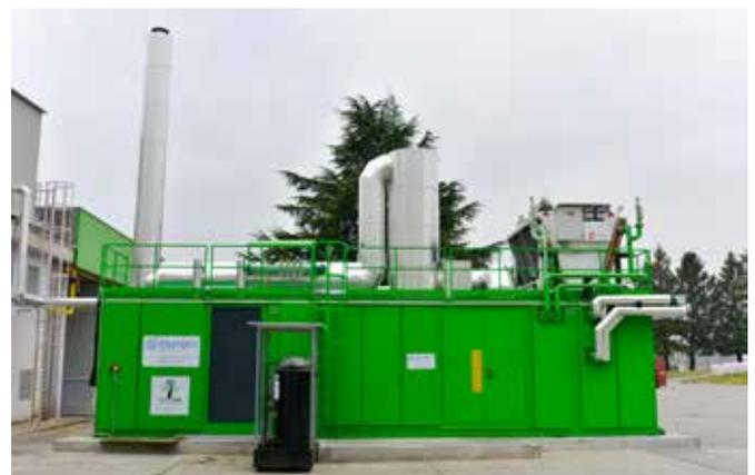
grado di "adattarsi" alle necessità del teleriscaldamento e di modificare l'energia termica in uscita operando sulla portata in funzione della quantità di calore richiesta. In questo modo si raggiunge un'efficienza (elettrica e termica) pari all'86%, valore molto alto rispetto alla concorrenza.
