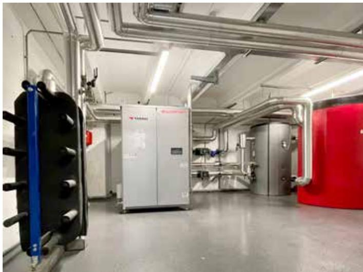
MAYA ha completato con successo l'installazione di un sistema innovativo di trigenerazione in cui la parte generativa non è il classico cogeneratore bensì un gruppo di compressori d'aria.
