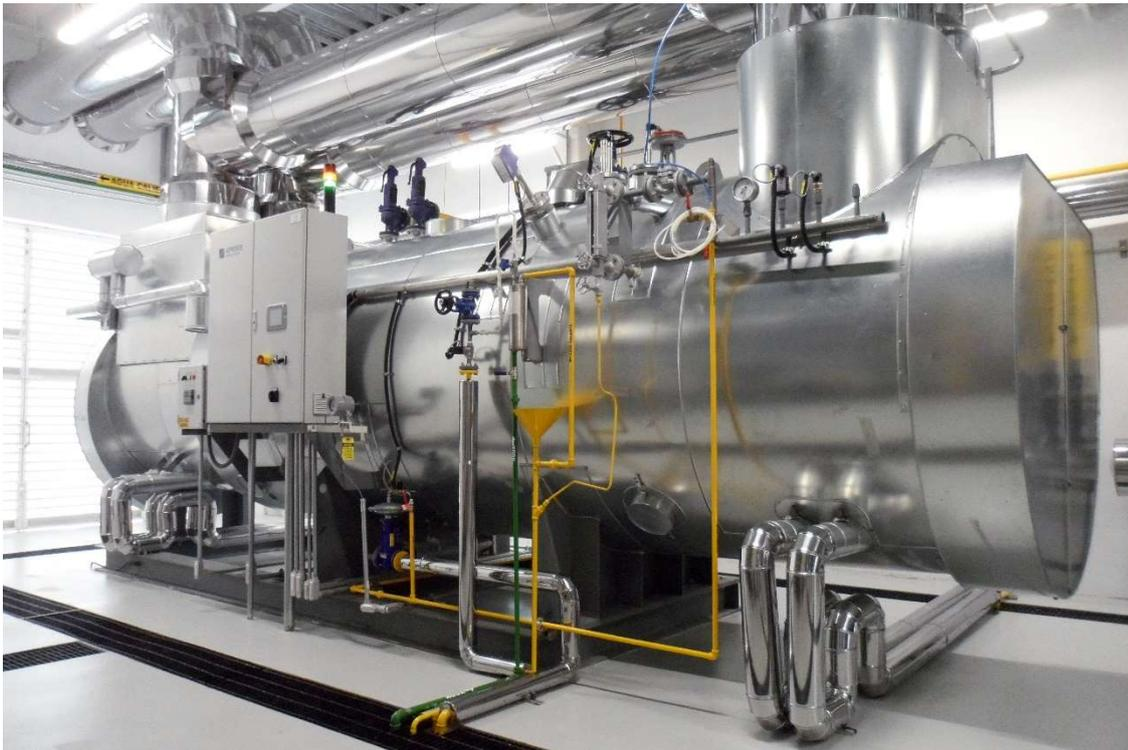
La normale ampiezza di banda dei parametri per vapore saturo o vapore surriscaldato è compresa tra 1 e 25 bar di sovrappressione (barg). Il sistema di generazione del vapore pronto per l'allacciamento contiene il corpo di base della caldaia con le dotazioni di sicurezza obbligatorie, tecnologia di controllo e regolazione, quando elettrico, isolamento, sistema di bypass del gas di combustione e gruppo di pompaggio.
