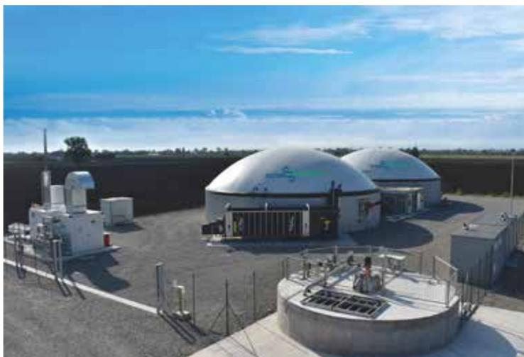
20m e un'altezza di 6, e sono dotate di coibentazione e miscelazione. Il caricamento delle matrici organiche liquide è affidato ad una vasca di pompaggio e miscelazione, mentre l'introduzione delle biomasse solide all'interno dei digestori avviene tramite una tramoggia di carico.
