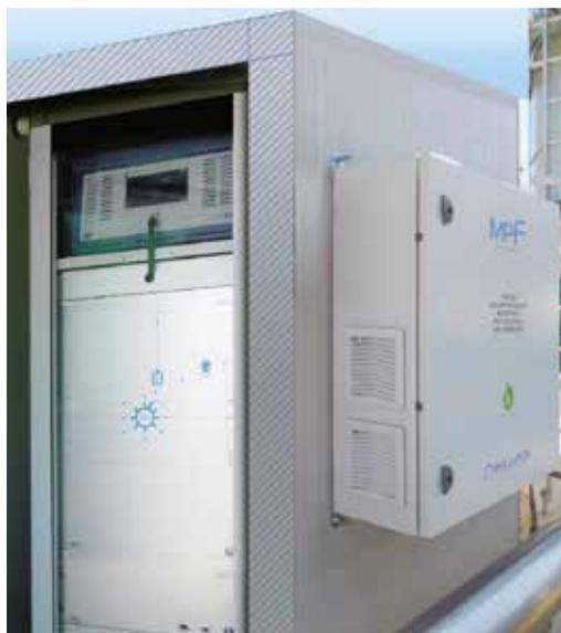
progettato per garantire che le caratteristiche del gas restino inalterate sino all'ingresso dell'analizzatore ed evitare l' indesiderato "effetto matrice" tra i vari punti di campionamento.
