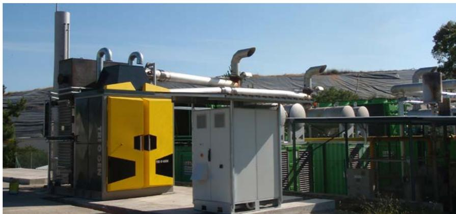
Dal 2001 Triogen sviluppa e produce sistemi cogenerativi a Ciclo Rankine Organico (ORC) con una resa di 165kW<sub>e</sub>. Il generatore ORC Triogen converte il calore residuo e la biomassa in pregiata elettricità ed energia termica, utilizzabili sia dai gestori di rete elettrica sia dagli utenti finali.
