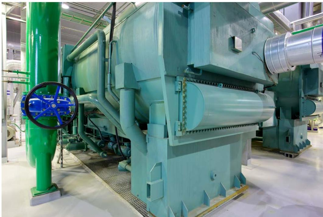
di vapore a recupero che produce 3.000 kg/ora di vapore saturo a 10 bar.
