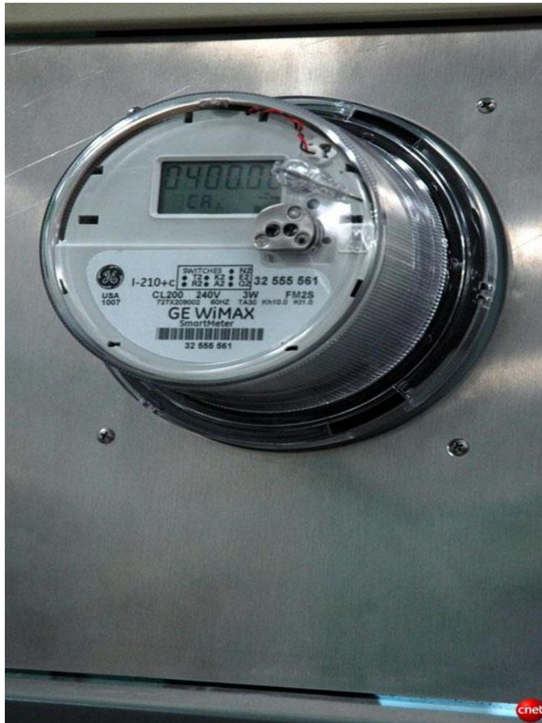
Fig. 5.5 Smart meter con comunicazione wi-max
