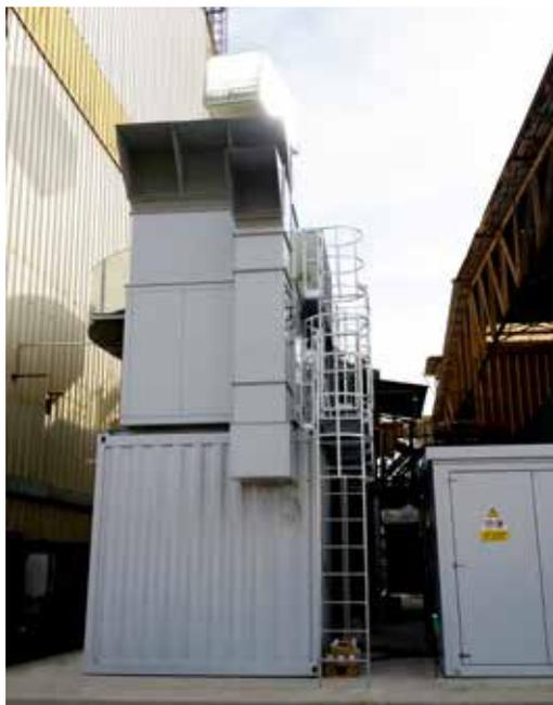
Un altro entusiasmante progetto è stato affrontato e portato a compimento con grande successo da Enerblu Cogeneration: si tratta di un impianto innovativo da 1.200 kWe che sfrutta tutta l'energia termica di recupero dal motore endotermico (acqua e fumi) e la cede all'utenza sotto forma di aria calda.
