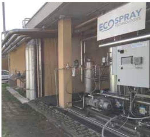
Ecospray Technologies S.r.l. ha sviluppato negli ultimi anni un'innovativa soluzione denominata ECO-SORB VPSA (Vacuum Pressure Swing Adsorption) per l'upgrading del biogas a biometano e che è stata anche recentemente brevettata.
