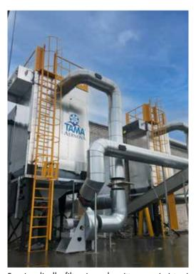
Funzionali alla filtrazione descritta sono i sistemi DeSO<sub>x</sub> e DeNO<sub>x</sub>, studiati ed ingegnerizzati da TAMA AERNOVA, che attraverso l'additivazione di sostanze come calce idrata, bicarbonato di sodio, carboni attivi e urea/ammoniaca, permettono la neutralizzazione dei gas acidi e l'abbattimento dei metalli pesanti generati durante i processi di combustione.
