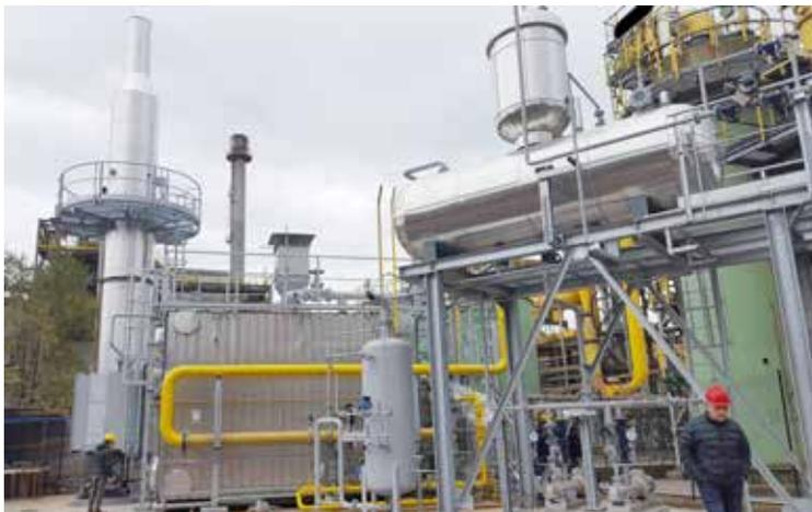
tal proposito Tecnoterm ha sviluppato una soluzione per la produzione di vapore al servizio dello stabilimento in grado di valorizzare energeticamente il gas di cokeria residuo di processo, che prima invece non veniva sfruttato.
