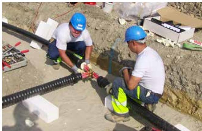
Una vasta gamma di accessori, pezzi speciali e raccordi ad espansione permettono di realizzare le reti idrotermosanitarie a perfetta regola d'arte con la massima garanzia della tenuta del sistema. I nuovi kit di ripristino giunzione in ABS, con chiusura a clips, consentono un rapido, facile e sicuro montaggio.
