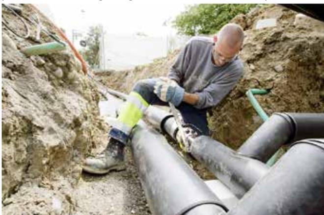
sente un rapido collegamento alle condotte tradizionali e agli impianti termici esistenti, con un notevole risparmio dei costi. Non sono infatti previste operazioni di saldatura, né di calibratura. Il collegamento alla centrale termica e alla rete principale è agevolato dall'ampia gamma di raccorderia progettata e brevettata da BRUGG.
