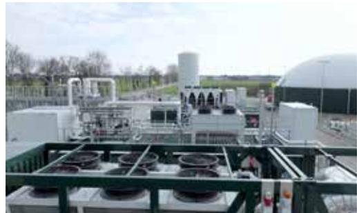
**Foto di AB Impianti - impianto di produzione di biometano con ventilatori ZPlus a servizio degli scambiatori di calore**
