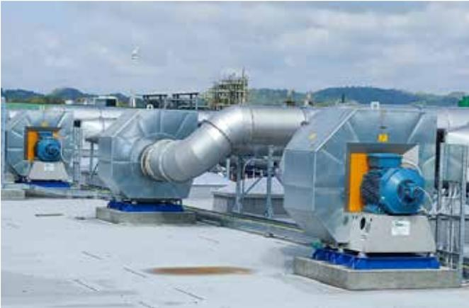
**Serie di ventilatori PBN installati in un impianto produzione Biogas**
