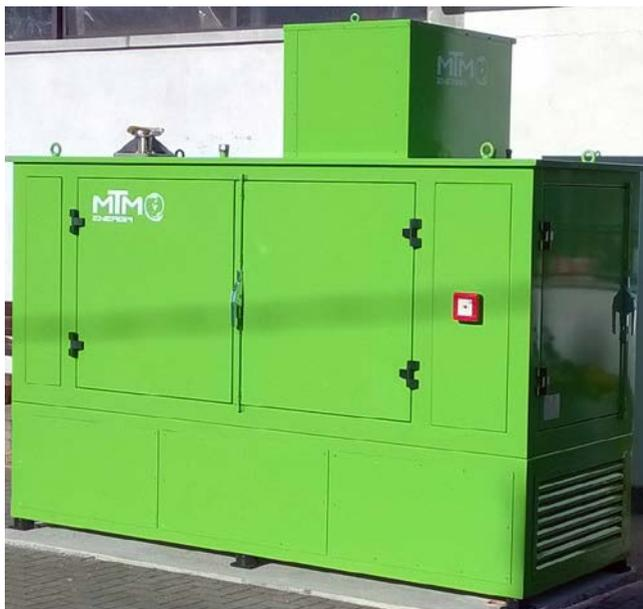
zioni interrato per il trasporto dell'acqua calda prodotta dall'impianto e dalle sottostazioni di teleriscaldamento necessario per cedere calore agli edifici. Il cogeneratore installato è compatto e supersilenzioso, si regola automaticamente in funzione del fabbisogno energetico degli edifici connessi alla rete ed è telecontrollato e supervisionato costantemente dai tecnici dell'area service MTM Energia e dal personale del Comune.
