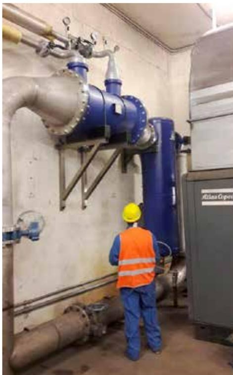
no concepiti per il trattamento dell'aria di processo per la produzione di acqua calda. La serie AIR, come le altre due sotto-serie BIO e HR, è ideata per recuperare energia termica da gas tecnici. Se non raffreddati, questi gas sarebbero dispersi in atmosfera contribuendo a effetto serra e inquinamento. L'utilizzo di questo tipo di scambiatori, invece, permette la riduzione della domanda di energia elettrica e termica con una sensibile riduzione dell'utilizzo di combustibili fossili.
